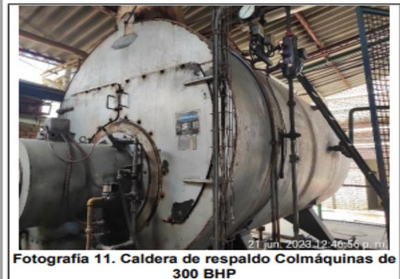
**Fotografía 11. Caldera de respaldo Colmáquinas de 300 BHP**
