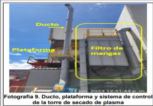
**Fotografía 9. Ducto, plataforma y sistema de control de la torre de secado de plasma**
