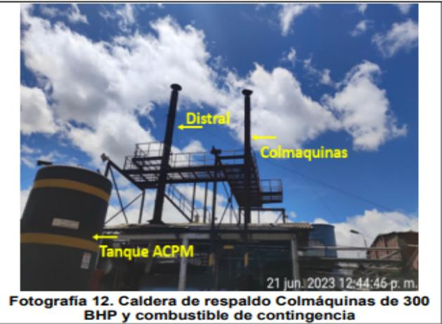
**Fotografía 12. Caldera de respaldo Colmáquinas de 300 BHP y combustible de contingencia**
