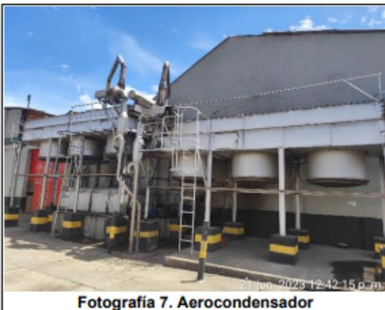
Fotografía 7. Aerocondensador
